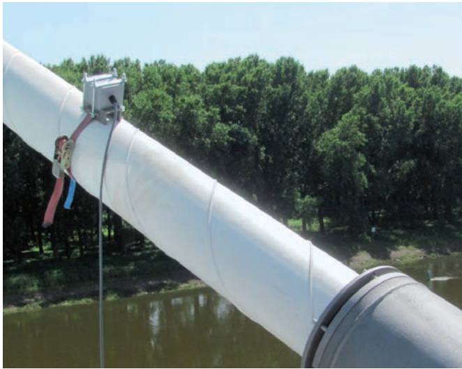
Bild 5 Sensormontage am Schrägseil Installation of sensor on cable
