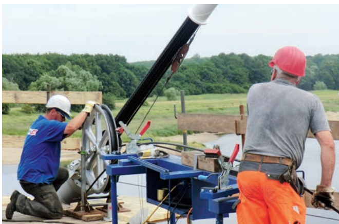
Bild 4 Litzenmontage Installation of strands
