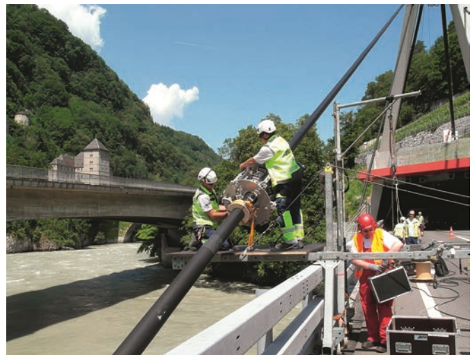
Bild 3. Aufsetzen der magnetinduktiven Prüfeinheit für Seile bis 250 mm
