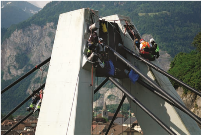
Bild 4. Endoskopie, Ultraschall und visuelle Untersuchung mit Seilzugangsverfahren (Fotos: Alpin)
