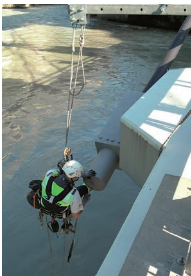
Bild 2. Techniker beim Öffnen der Verschlusskappen
